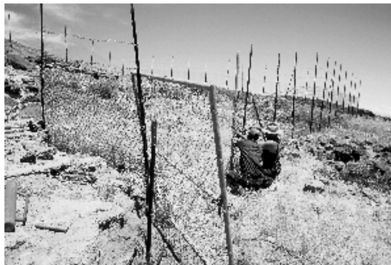
Construcción de trampas para cabras. Foto: GECI
